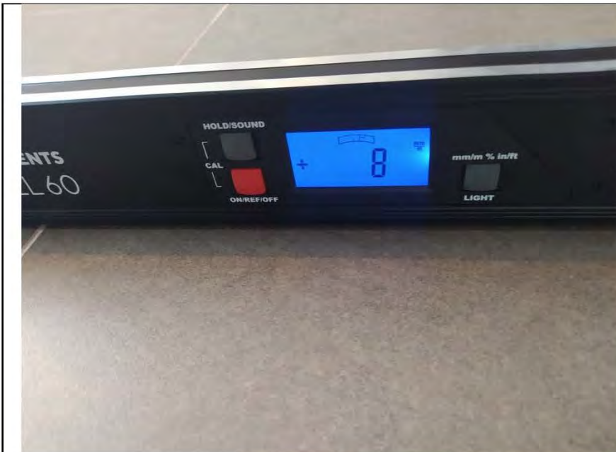
Фото №16. Измерение уровня напольного покрытия в кухне (керамическая плитка).
