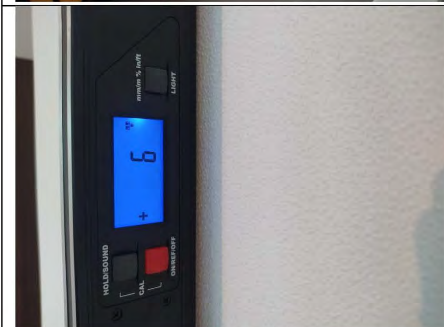
Фото №8. Измерение уровня стен в спальне.
