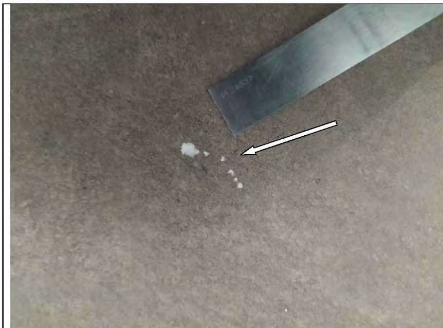
Фото №52. Напольная керамическая плитка в прихожей имеет сколы
