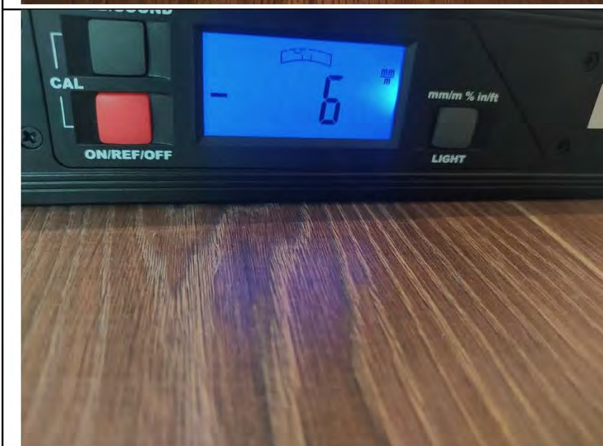
Фото №15. Измерение уровня напольного покрытия в гостиной
